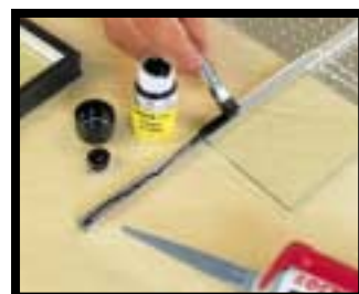
Primer Loctite® 7252 Pro lepení a utěšňování skla a glazovaných materiálů.
